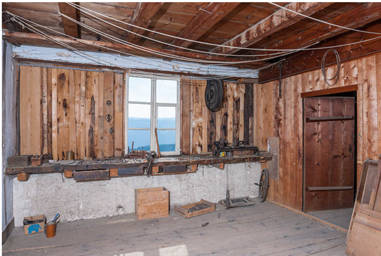
Ferme : atelier à l'étage en surcroît.
