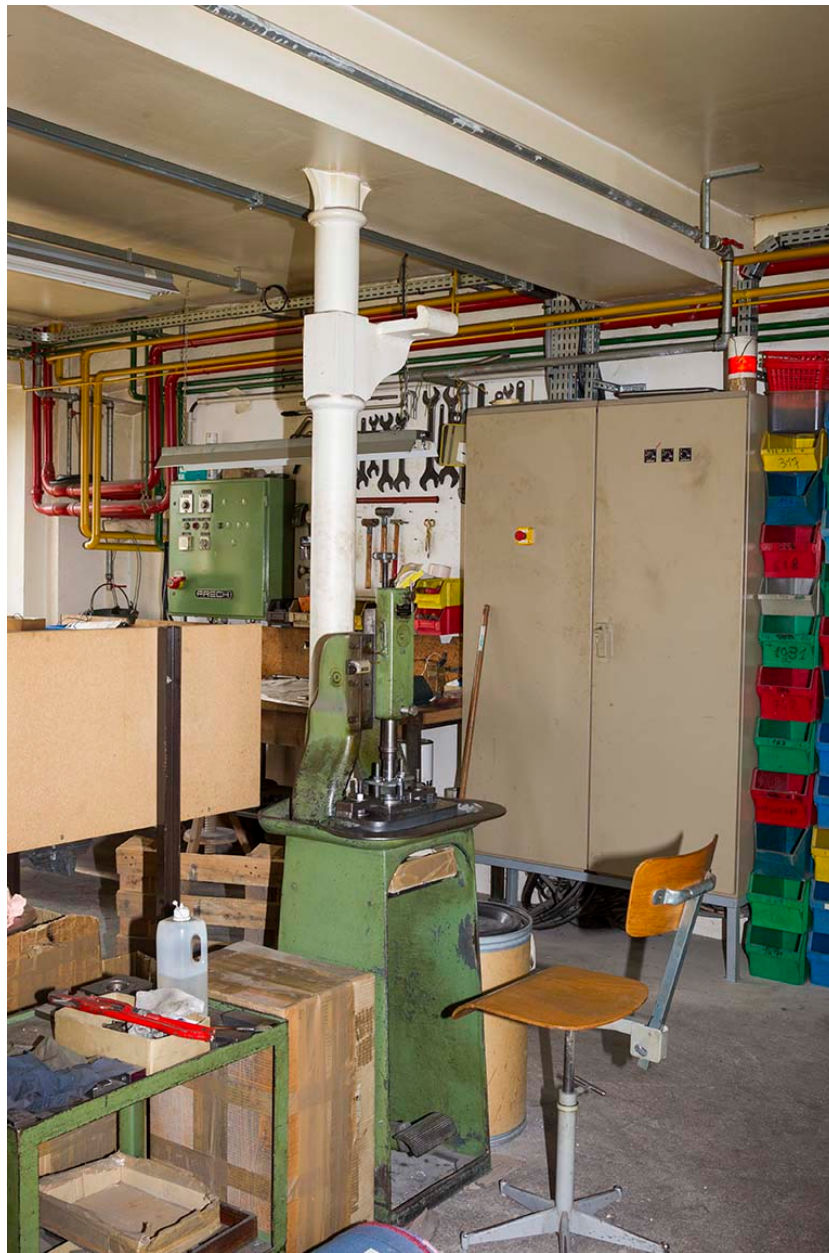
Usine, rez-de-chaussée : poteau de soutènement de l'étage.
