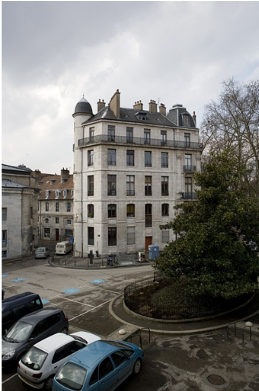
Vue d'ensemble de l'immeuble depuis la place Granvelle.
