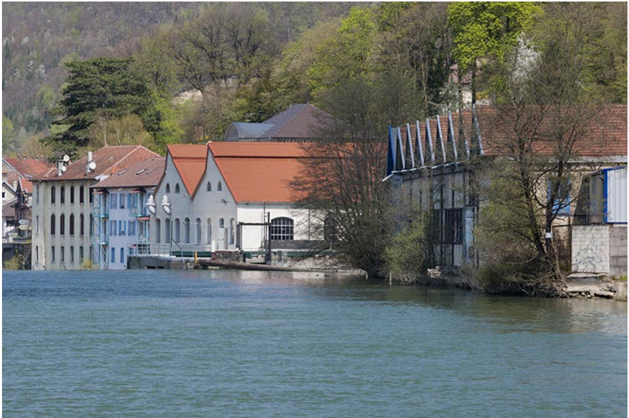
Vue de l'usine rive droite depuis l'amont.
