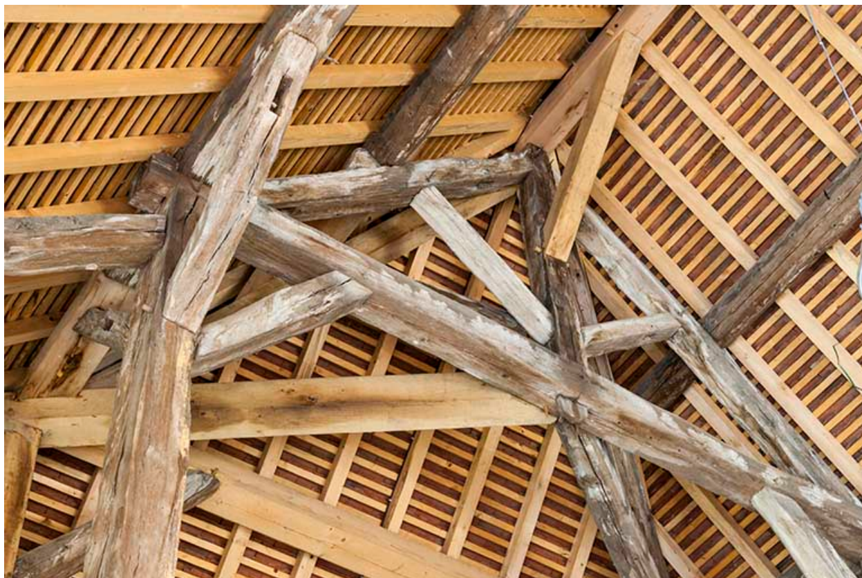
Détail de la charpente de la croupe.
