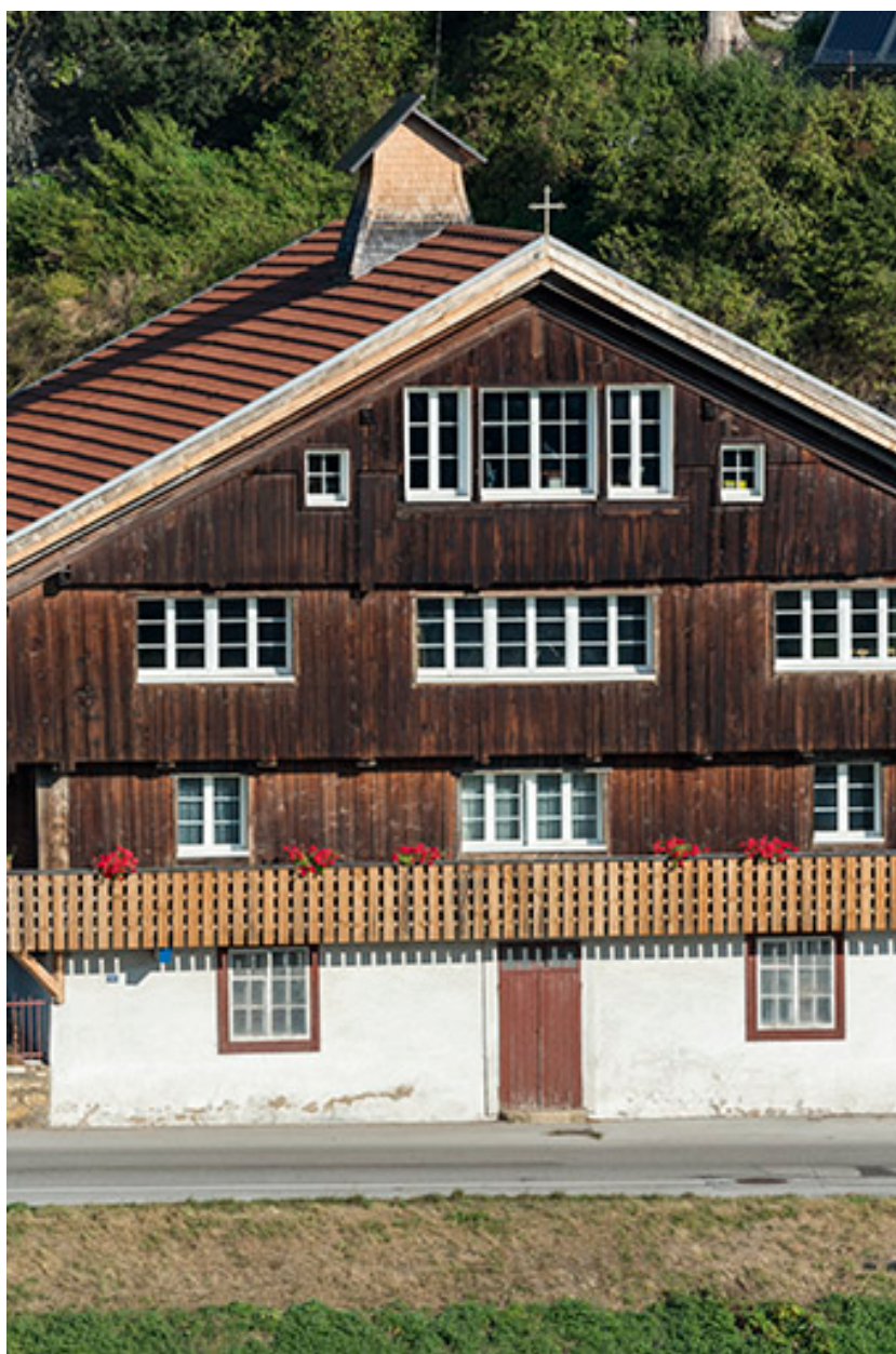
Façade antérieure : travées centrales.
