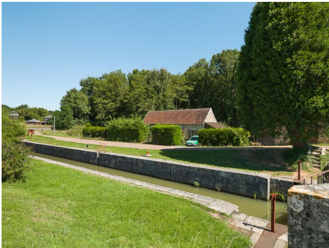
Vue du site d'écluse.
