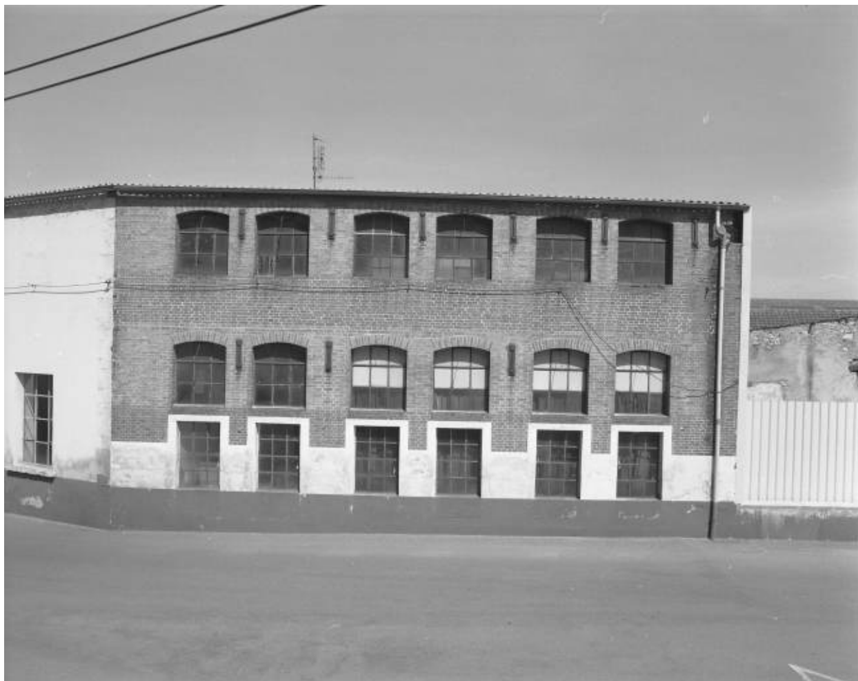
Atelier de contrôle. Vue de face.
