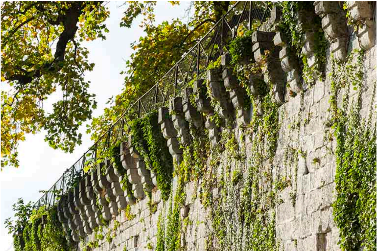
Détail de l'enceinte, au nord-est.
