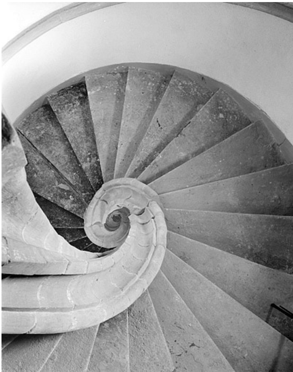
Escalier vu du niveau des combles.
