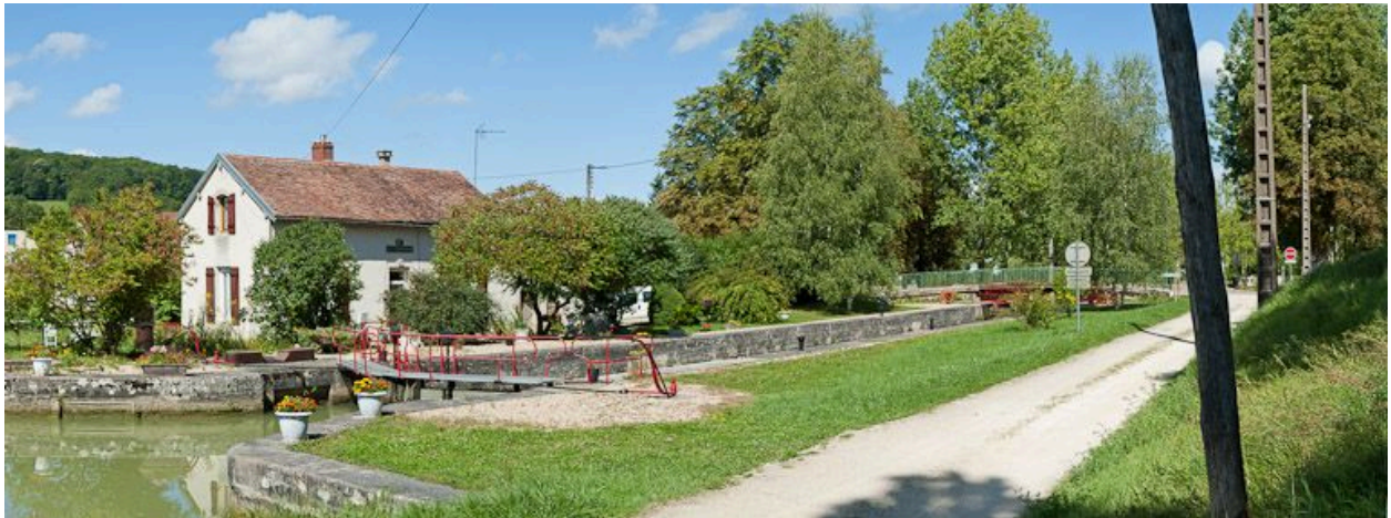
Vue d'ensemble du site d'écluse.
