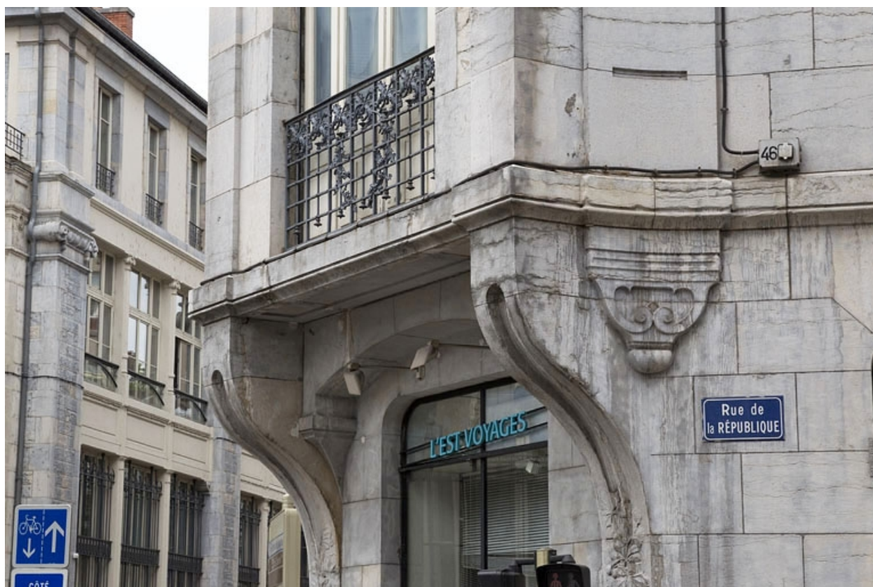
Façade d'angle : détail du rez-de-chaussée.
