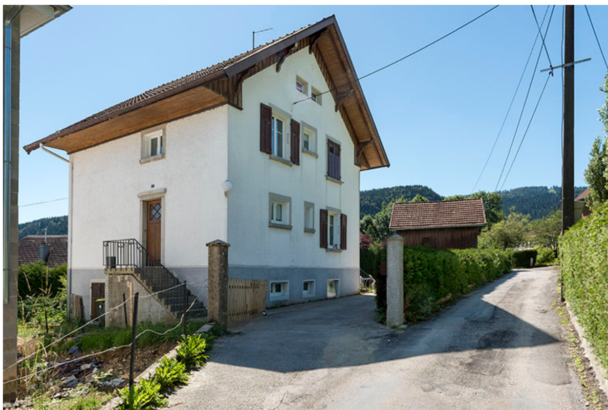
Maison : façades antérieure et latérale gauche.
