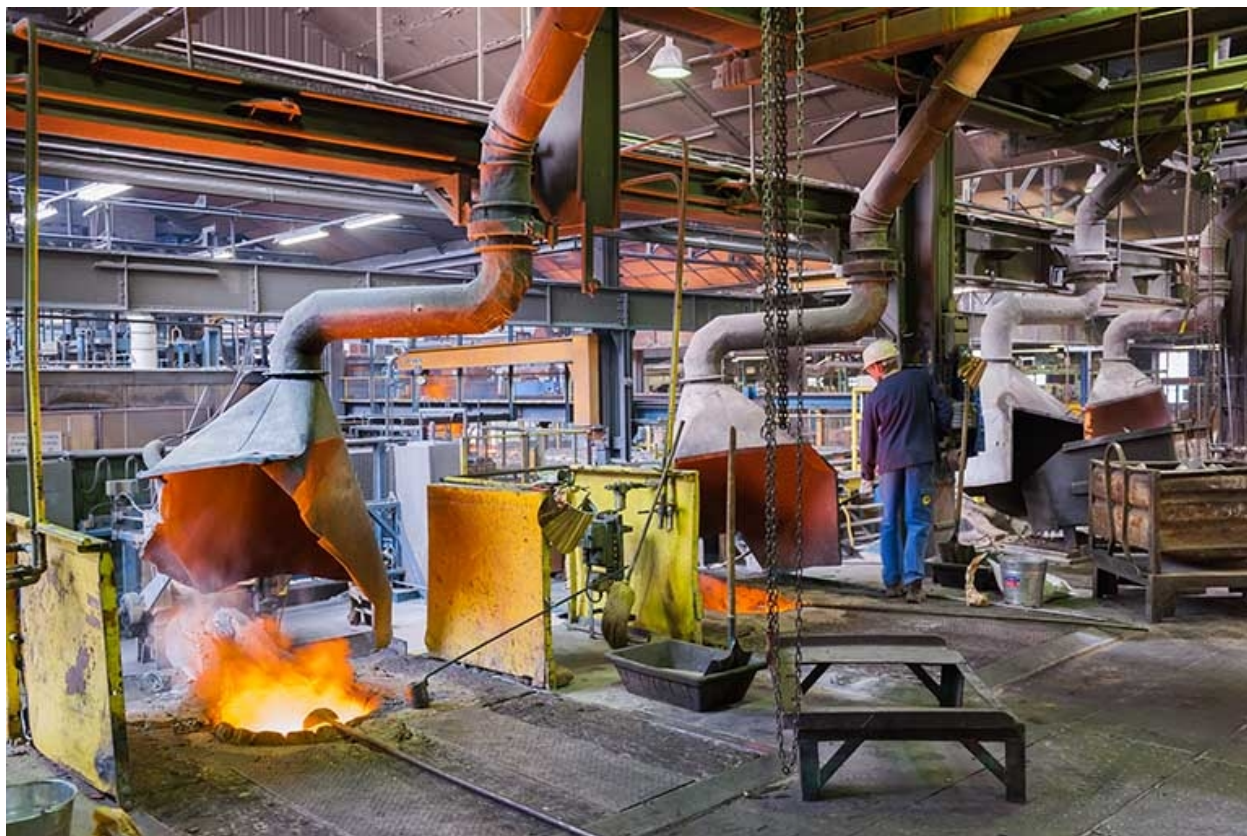
Partie supérieure des fours à induction.
