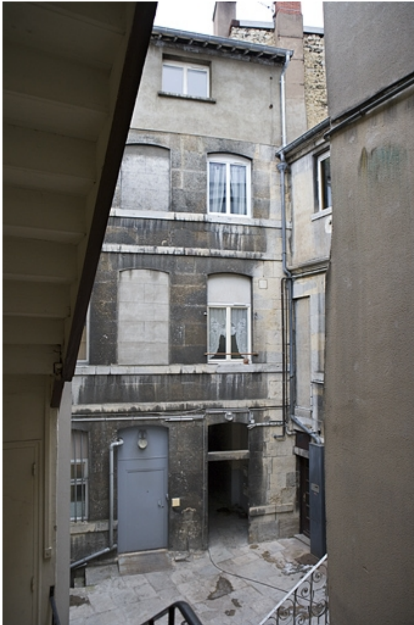
Façade postérieure du premier logis secondaire donnant sur la deuxième cour : 13 Grande Rue.
