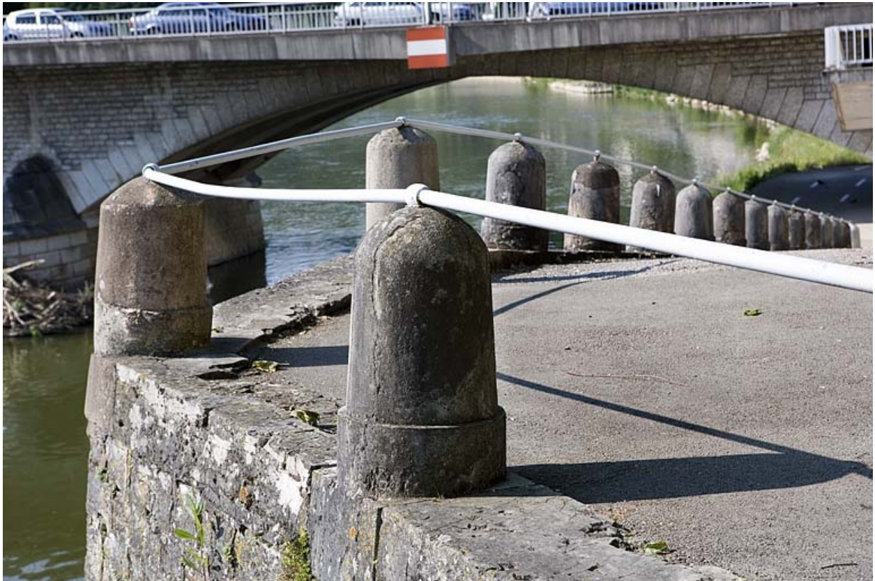
Bornes et garde-corps de la rampe d'accès.
