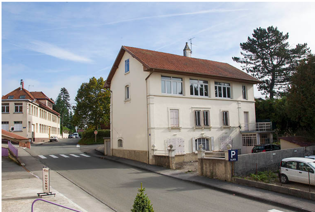
Façades antérieure et latérale gauche.
