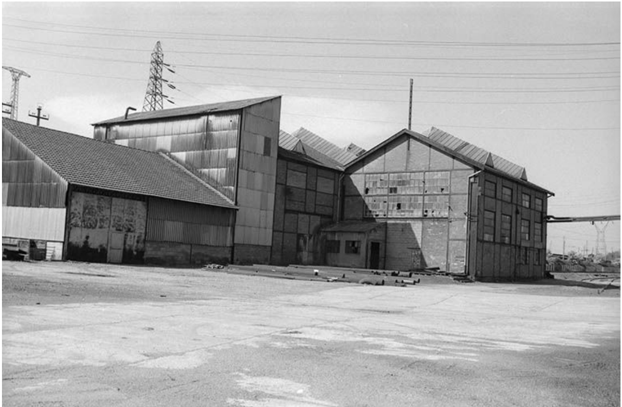
Magasins et ancien atelier " béton gaz " vus du sud.
