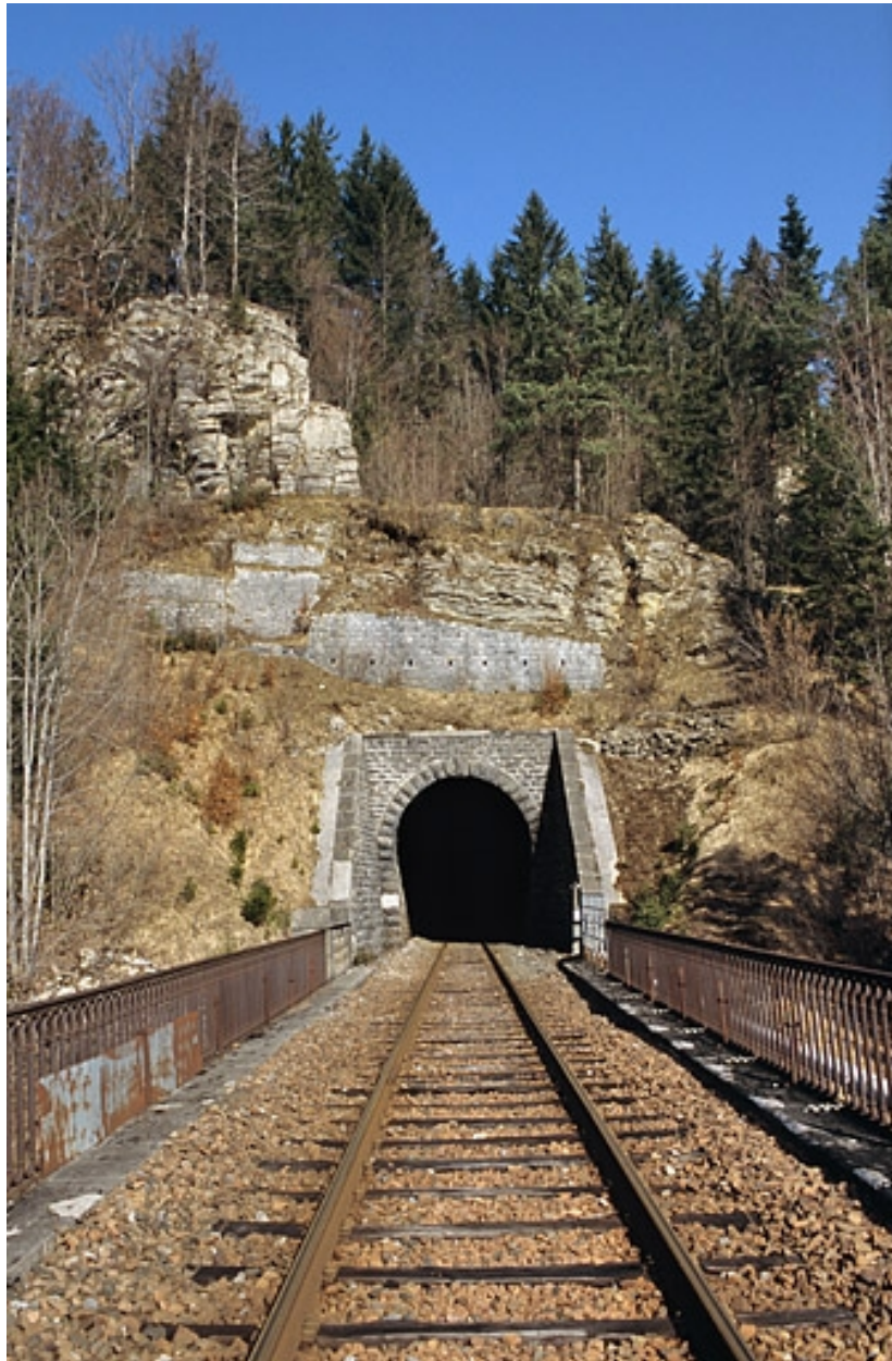
Tunnel : tête du côté La Cluse.
