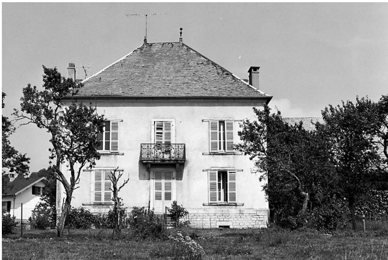
Façade postérieure du logis.
