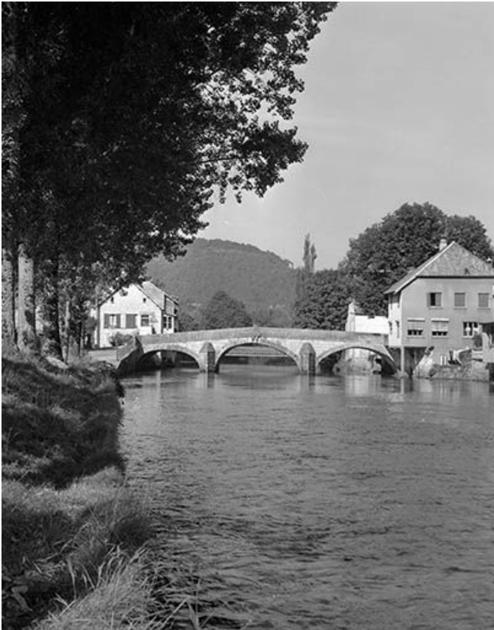
Pont sur la Loue.
