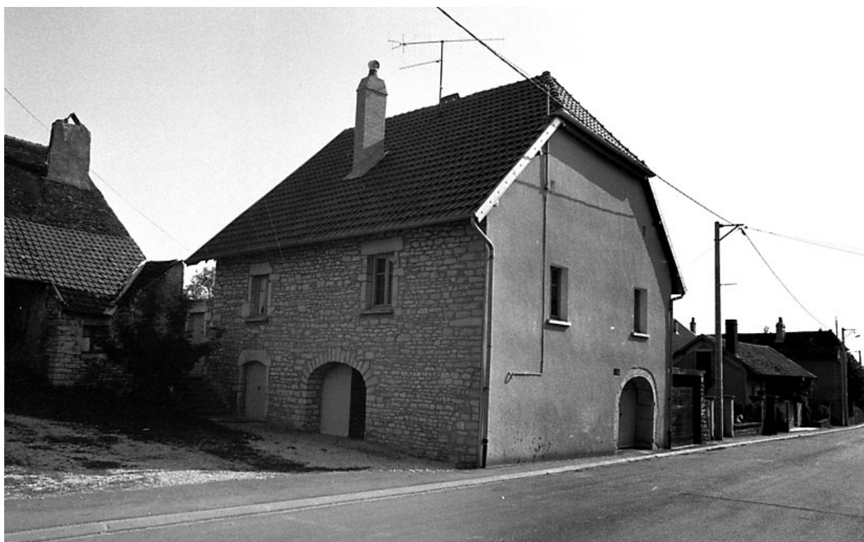
Brussey : maison de vigneron située Grande Rue.
