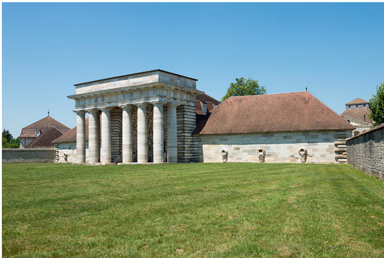
Bâtiment d'entrée. Vue de trois quarts droite.
