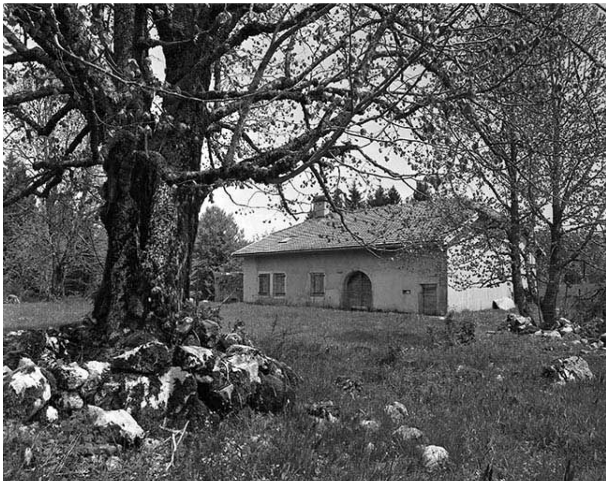
Vue éloignée de la façade postérieure.
