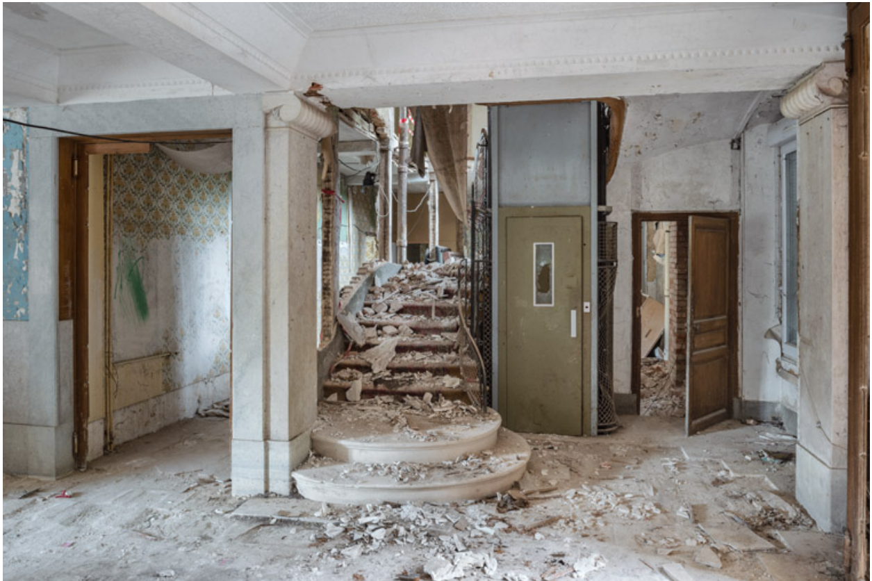
Hall d'entrée au rez-de-chaussée, vue en direction de l'ouest.
