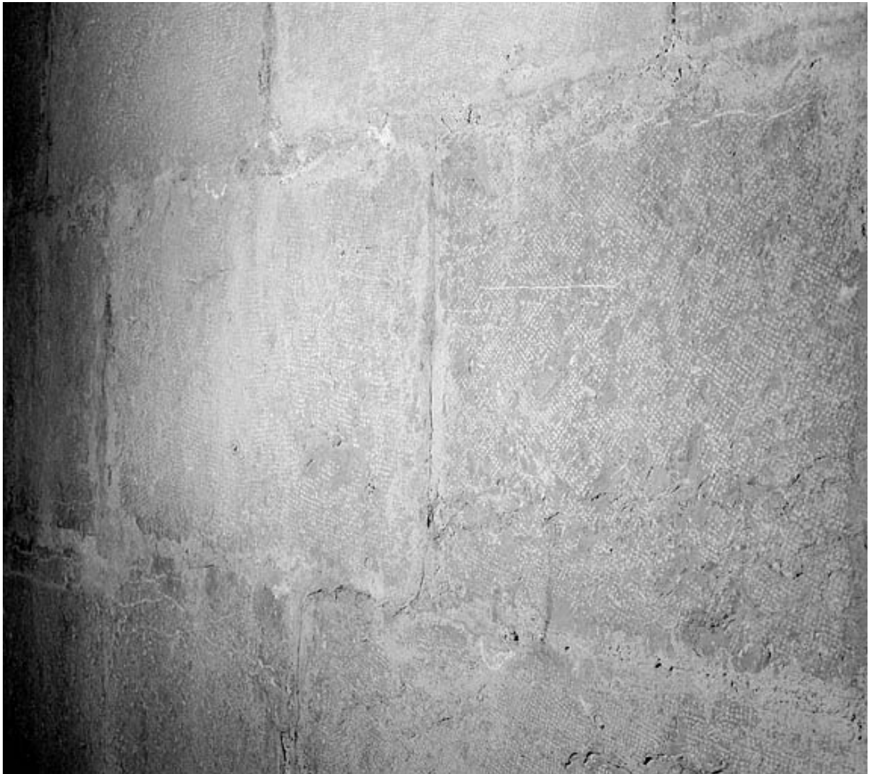
Détail du parement de la coursière haute au revers de la façade (traces de boucharde).
