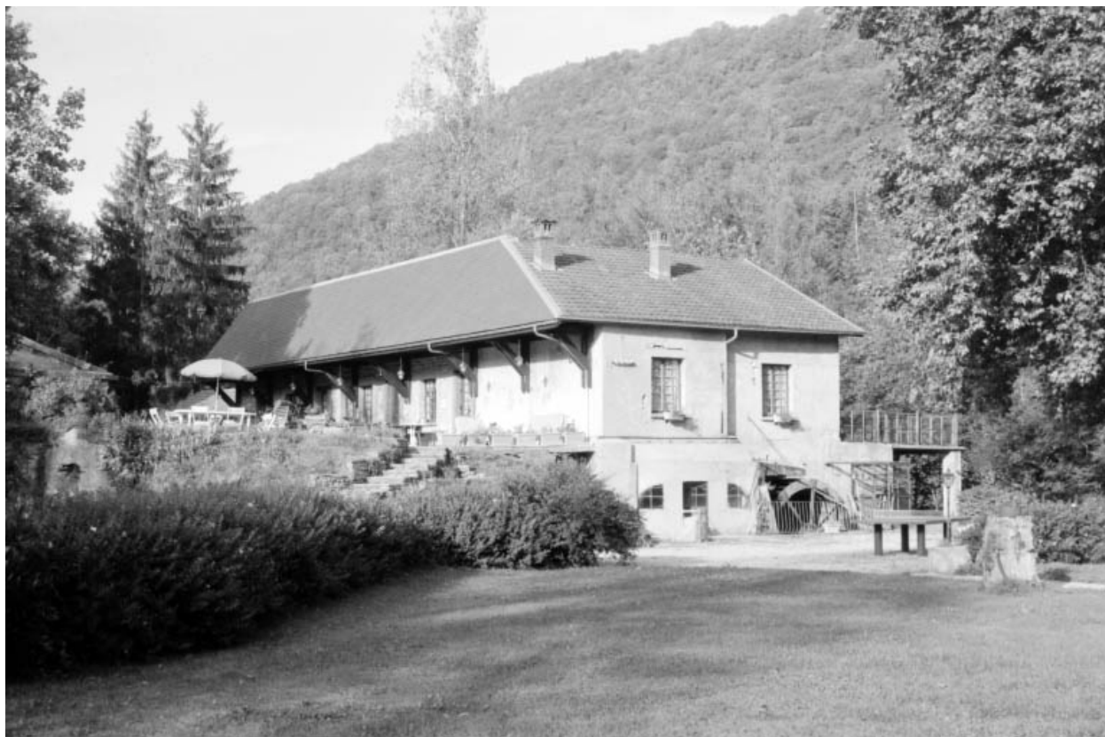
Bâtiment d'eau, vu de trois quarts droite.
