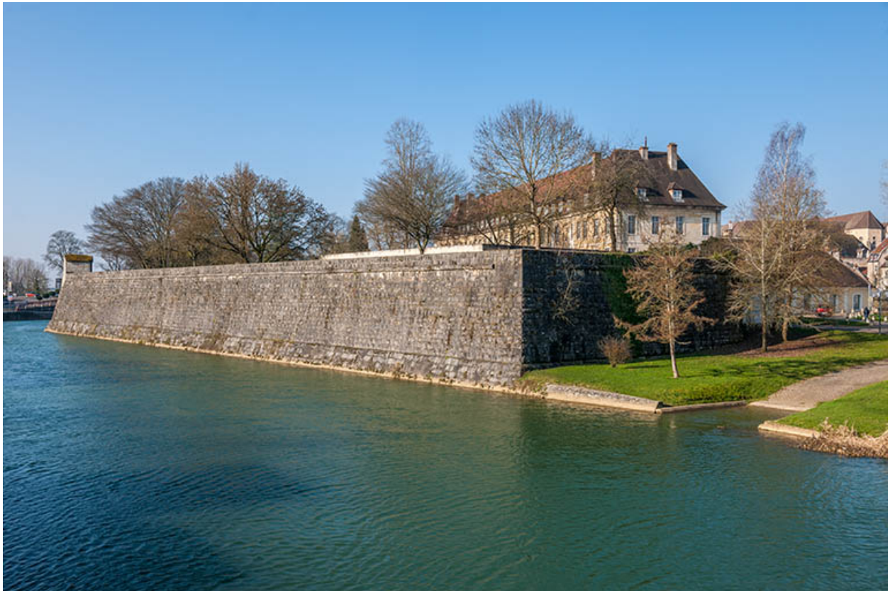
Ancien hôpital de la Charité, actuellement internat, vue du parc au bord du canal.
