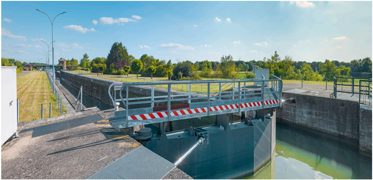
Vue d'ensemble des portes amont de l'écluse.
