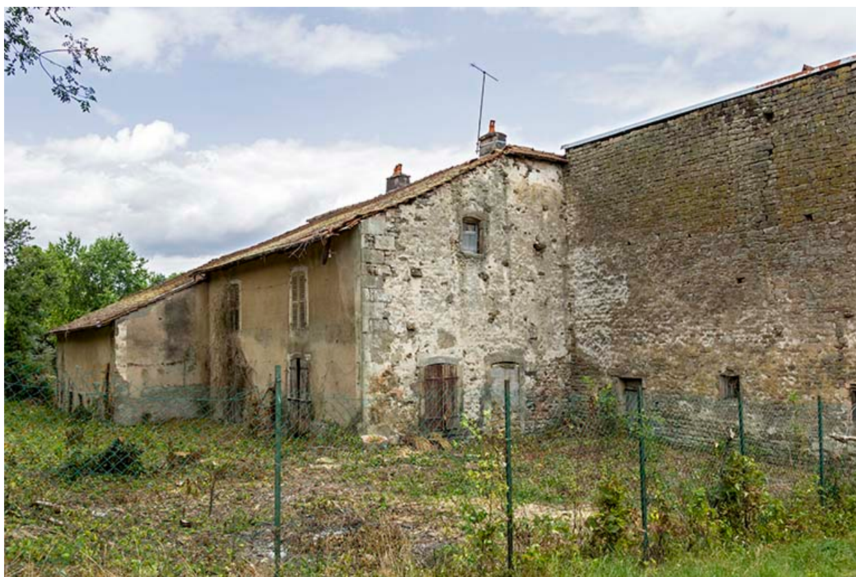
Vue générale sur la façade postérieure.
