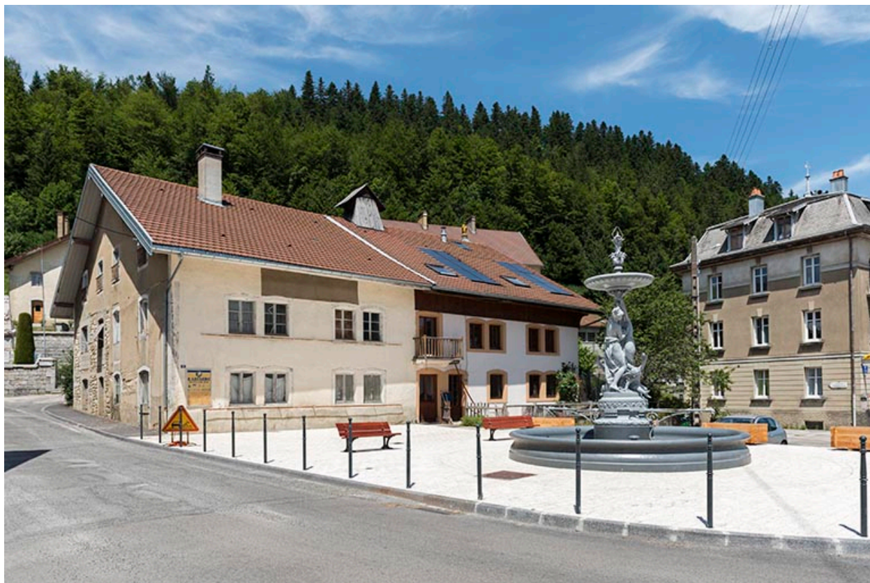
Vue d'ensemble du bâtiment et de la place.
