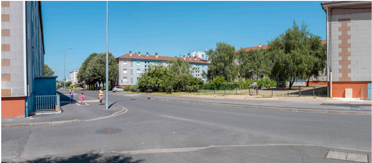
Vue depuis le croisement de l'avenue de la Paix et l'allée Antoine de Saint-Exupéry sur le square entre les bâtiments J, D et C.
