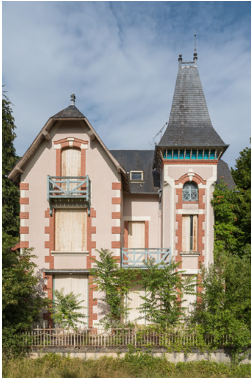
Façade principale, vue de face.
