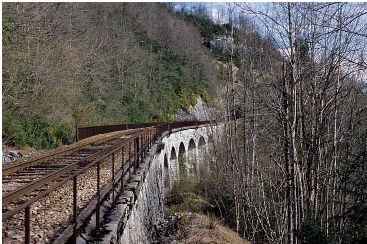
Viaduc de la Grande Roche : vue en enfilade, depuis le côté La Cluse (sud).
