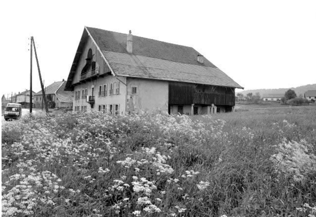
Façades antérieure et latérale droite.
