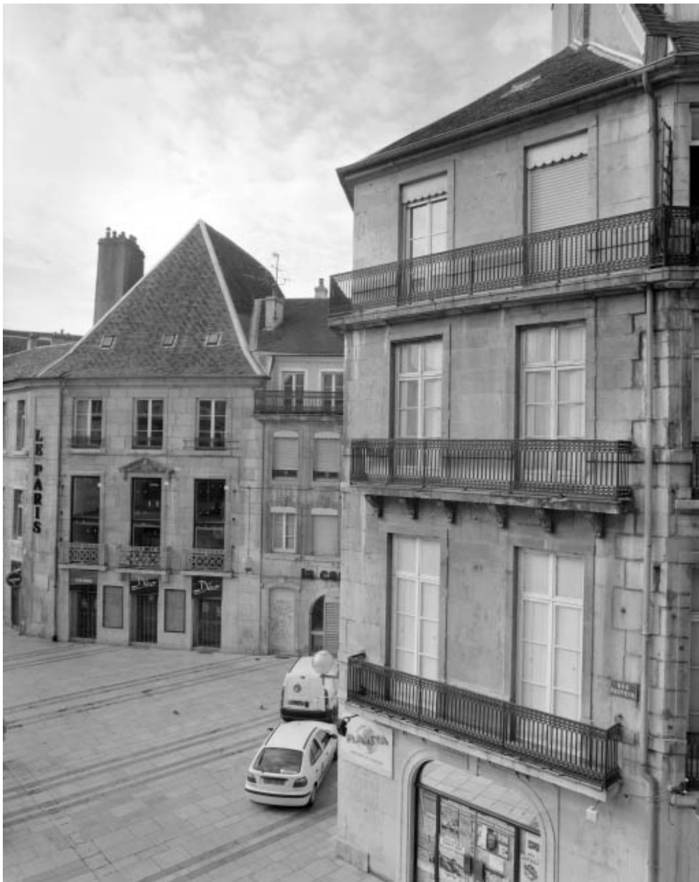
Façade sur rue, détail de la partie droite.
