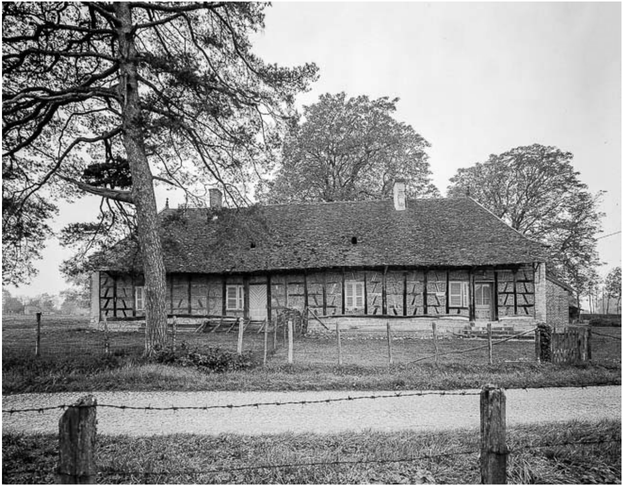
Bâtiment d'habitation vu de face en 1975.
