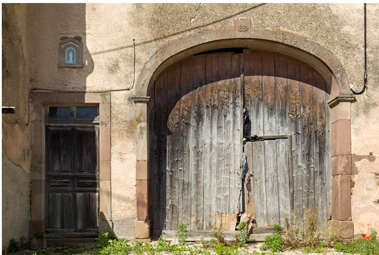
Portes de grange et du logis d'une ferme.
