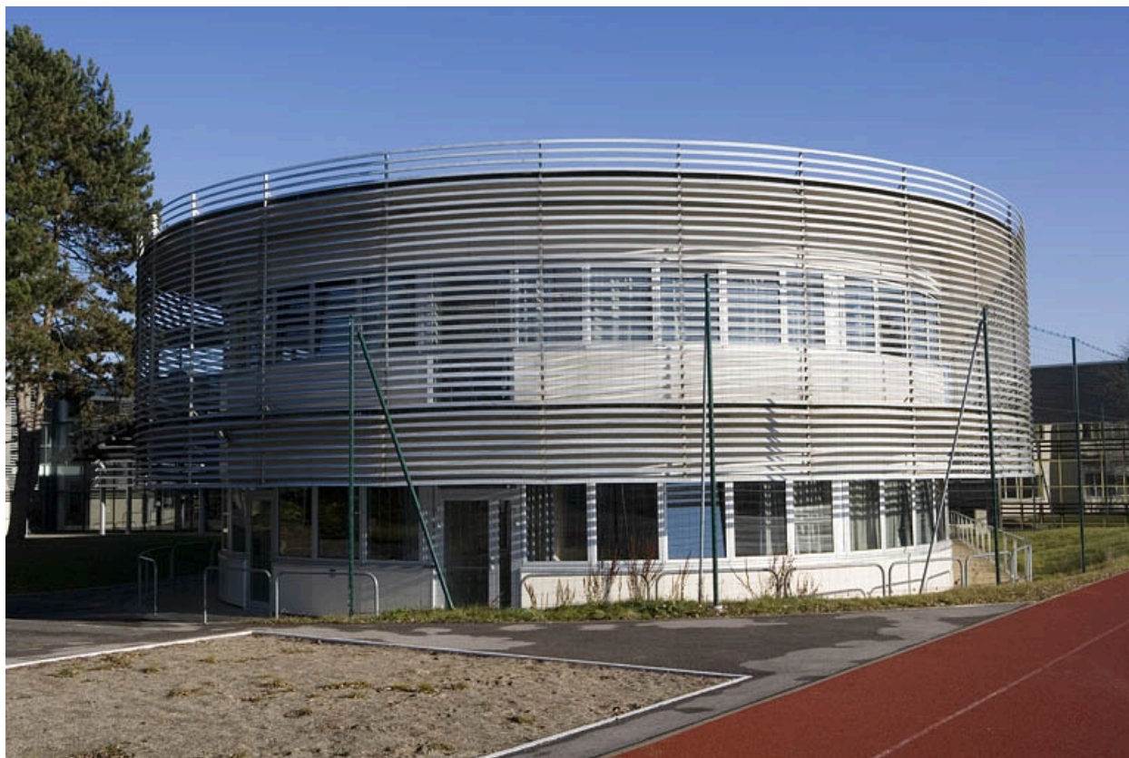
Vue de l'aile droite bâtiment L. Détail.
