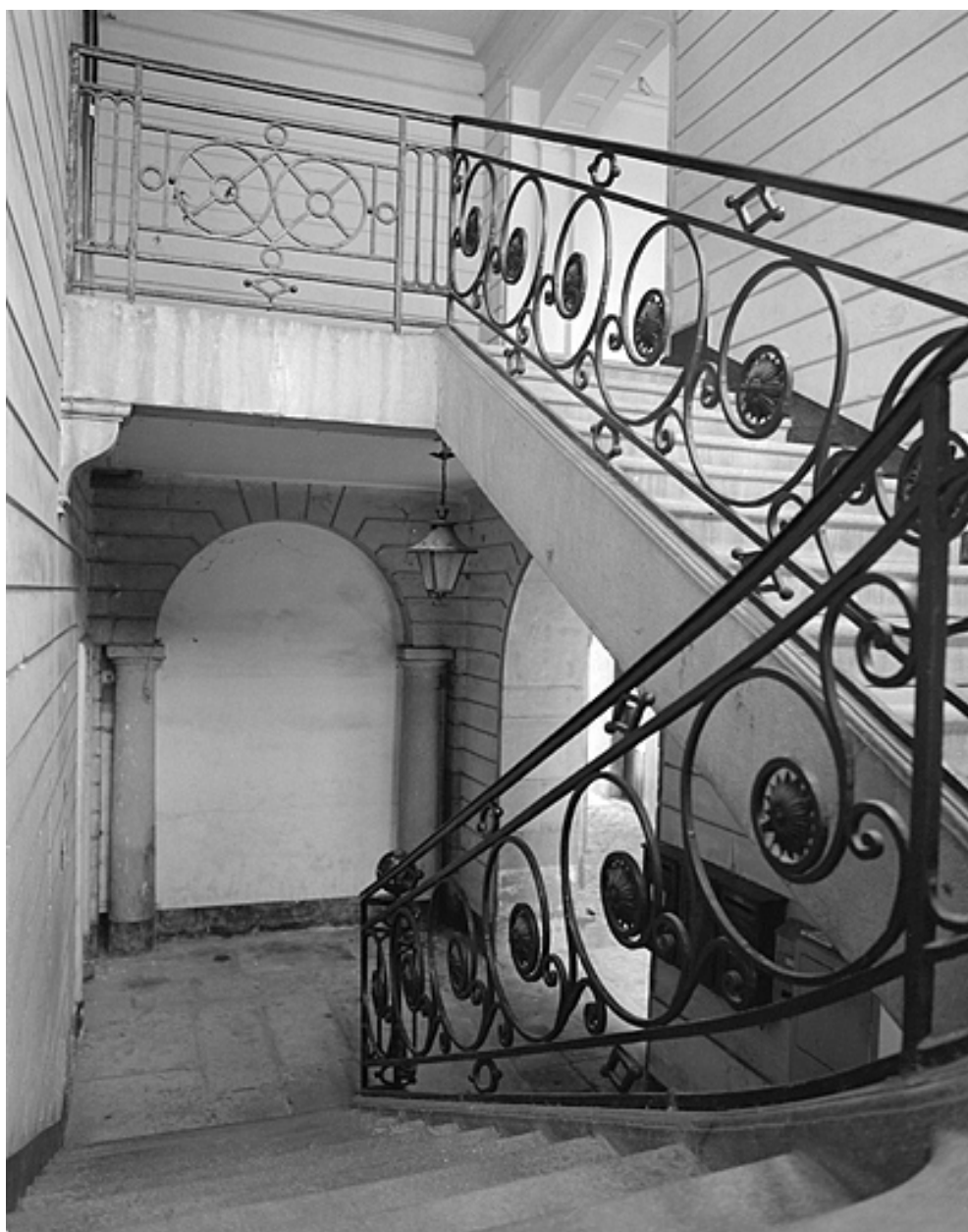
Vue de l'escalier depuis le repos.
