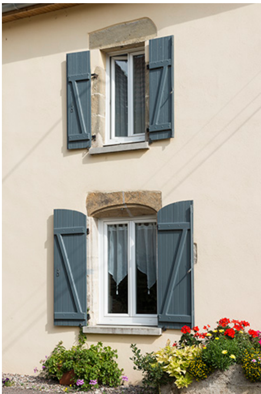
Détail sur les ouvertures, partie habitation.
