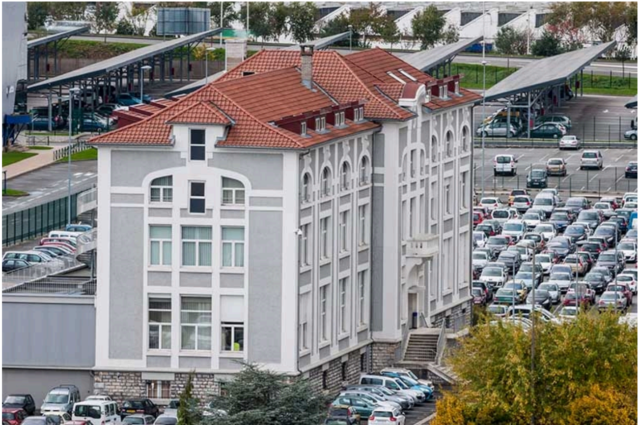
Bâtiment dit du Cercle, vu de trois quarts.
