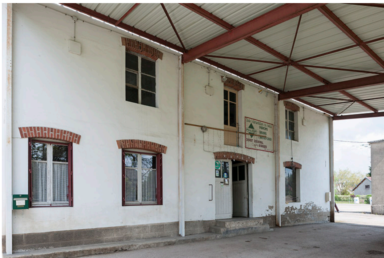
Façade est de la minoterie.
