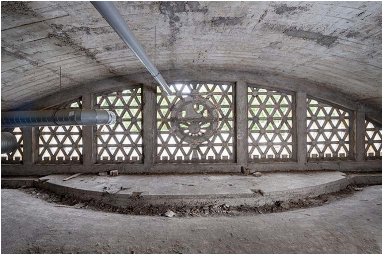
Fronton de la façade nord, vue intérieure.
