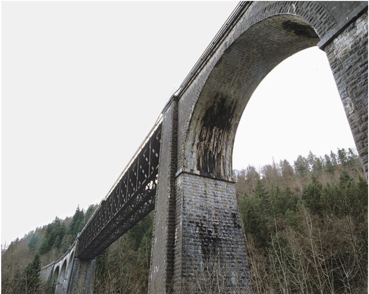
Troisième arche rive droite et travée métallique, vues par dessous.
