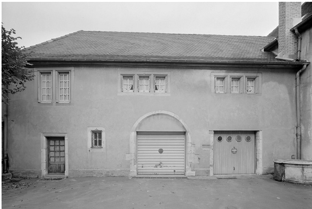
Aile gauche. Façade sur la cour.
