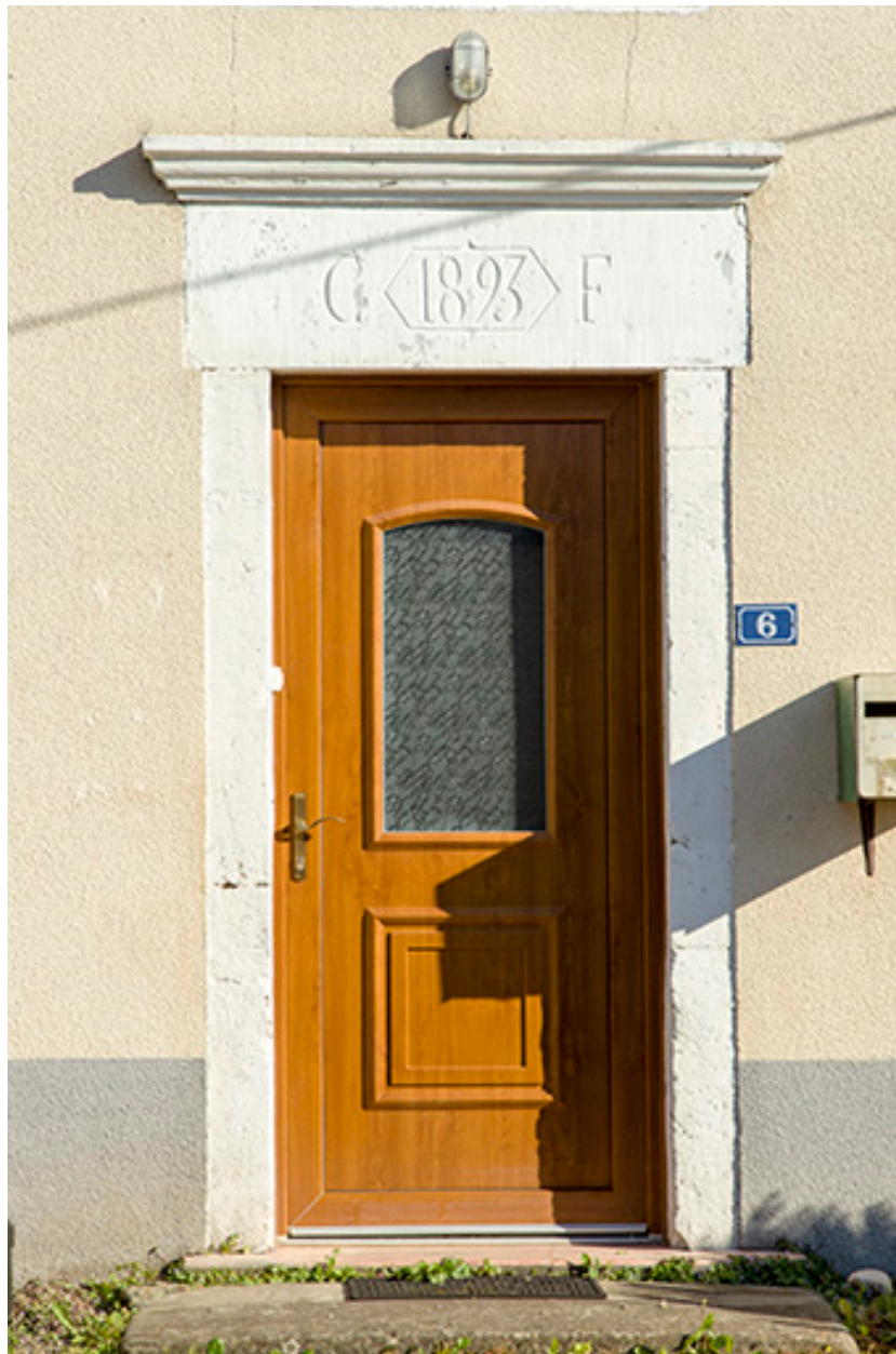
Porte avec date portée sur le linteau.
