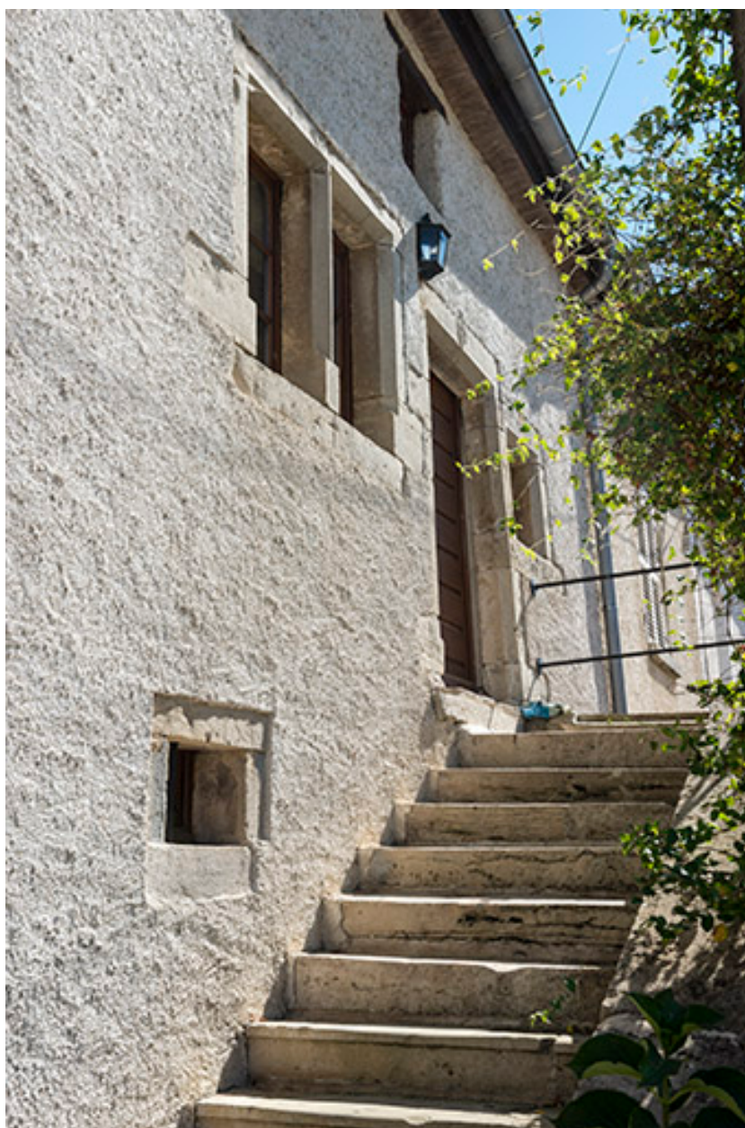
L'escalier extérieur permettant d'accéder à l'étage carré.
