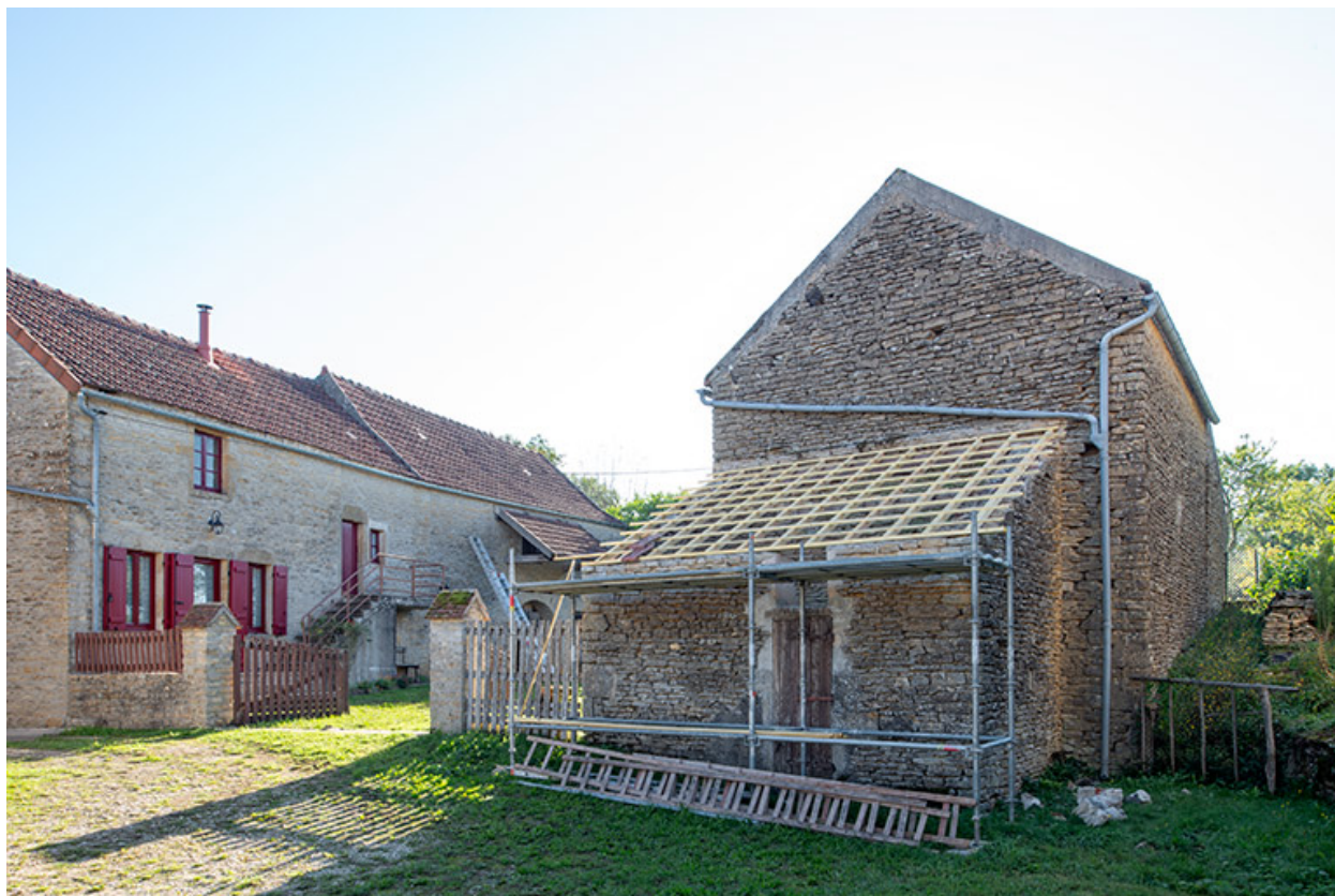
Le toit à porcs en travaux.
