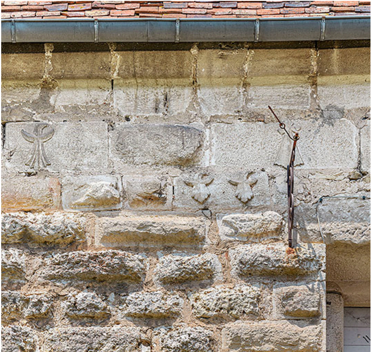
La maçonnerie en bossage de la porte.
